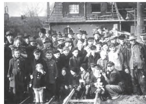
Ripshorster Straße: Bunkerbau, 1943/44; Quelle: www.riwetho.de
