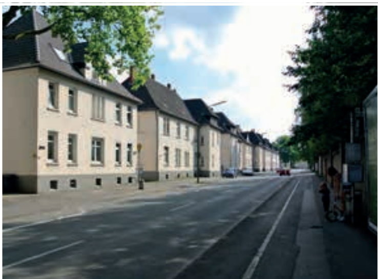
Fotos der Hansemann-Siedlung: obere Reihe Häuser der Bauphase I,
