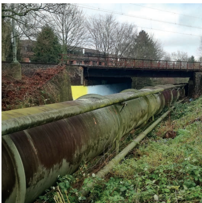
HHW- Sonderbauwerk S-Bahn Brücke Massener Weg, Dortmund (Bild: © RVR)
