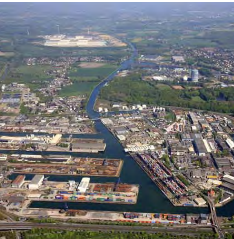
Abb. 33: Der Dortmunder Hafen gilt als größter Kanalhafen Europas
