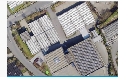
Gebäudebegrünung und Baumbepflanzung bei Orthopädie Kall in Remscheid
