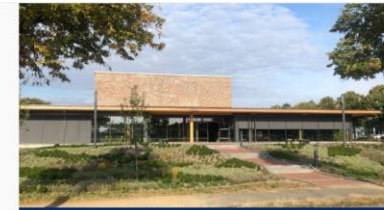
Nachhaltiges Wassernutzungskonzept für das Kreishaus Viersen durch die Lagus GmbH
