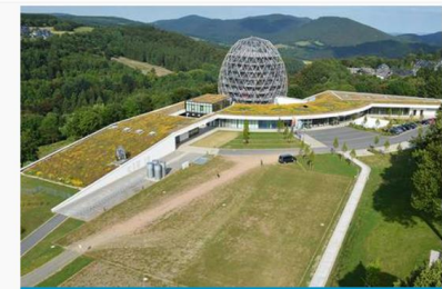
Gründach Oversum in Winterberg von Optigrün Gründach mit automatischer Regelung von Wasserabfluss-,
