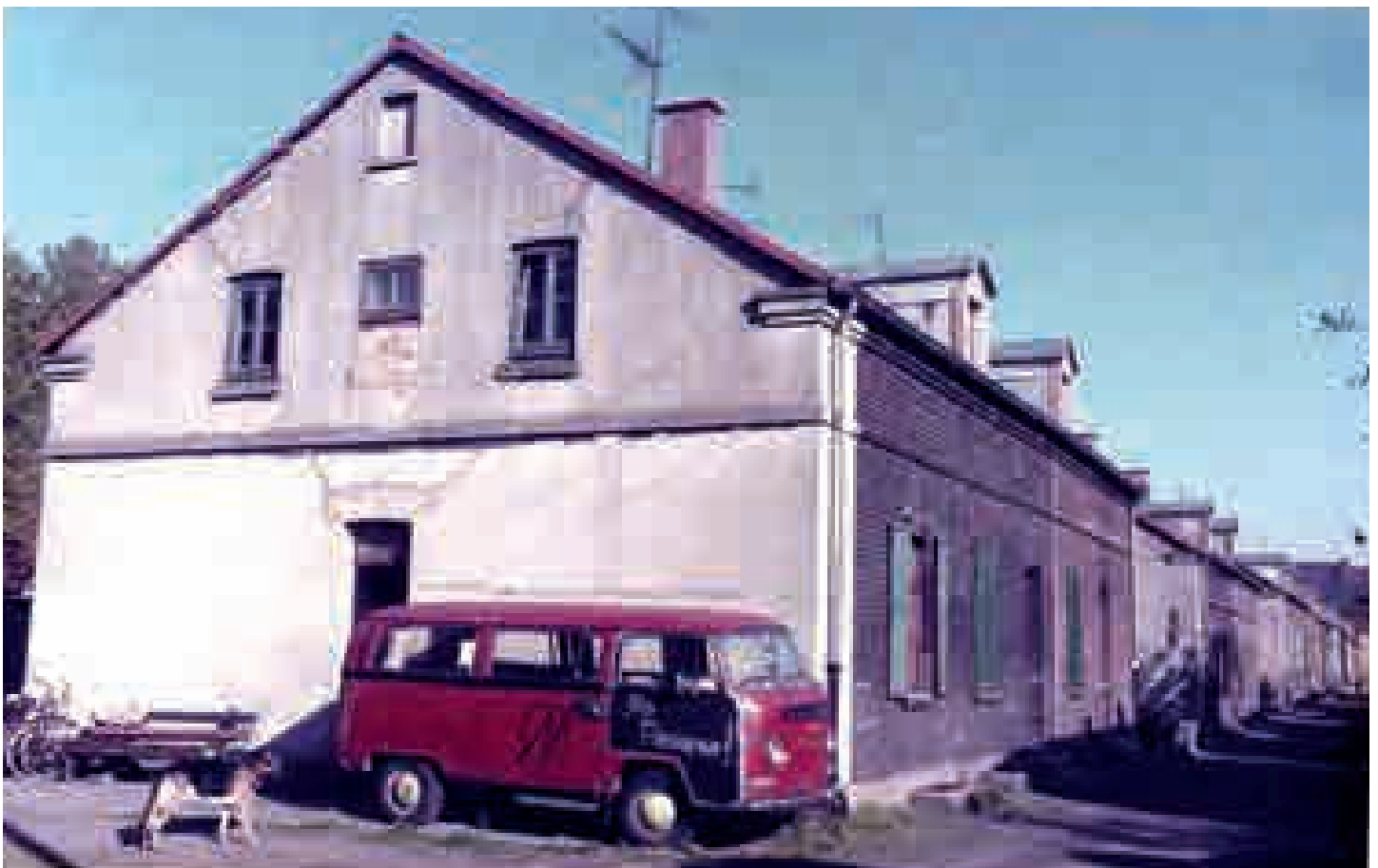
Wohnsiedlung Gustavstraße; Quelle: Denkmalliste Wohnsiedlung Gustavstraße
