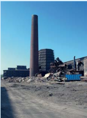
Westfalenhütte Dortmund, Rückbau
