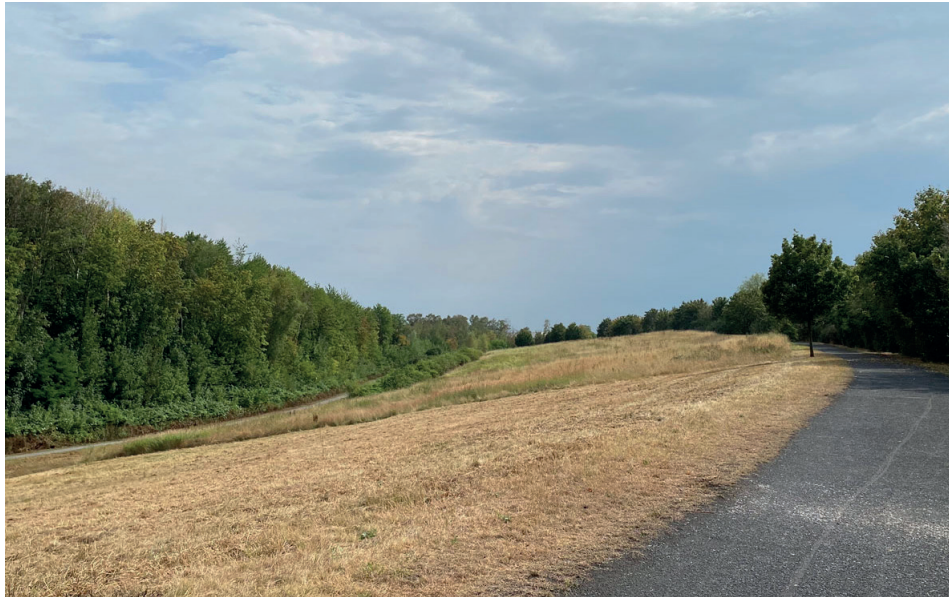
Abb. 33 An einigen Stellen sind Pflegemaßnahmen deutlich sichtbar
