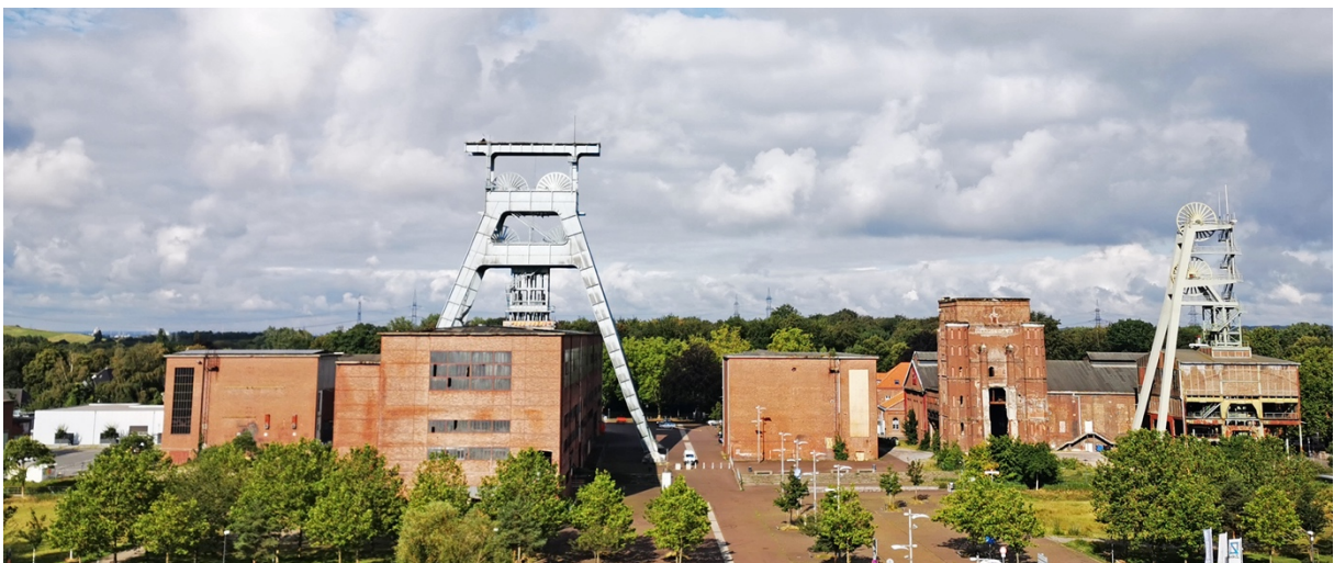
Bild 13: Das Gelände der ehemaligen Zeche Ewald (Foto: Jochen Schlutius, RTG)
